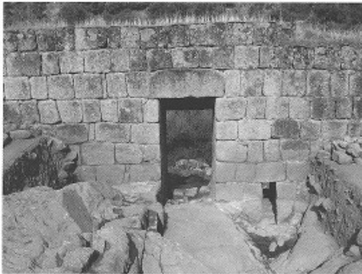
Fig. 12 - El Portillo 1, visto desde el interior, tras su excavación.
