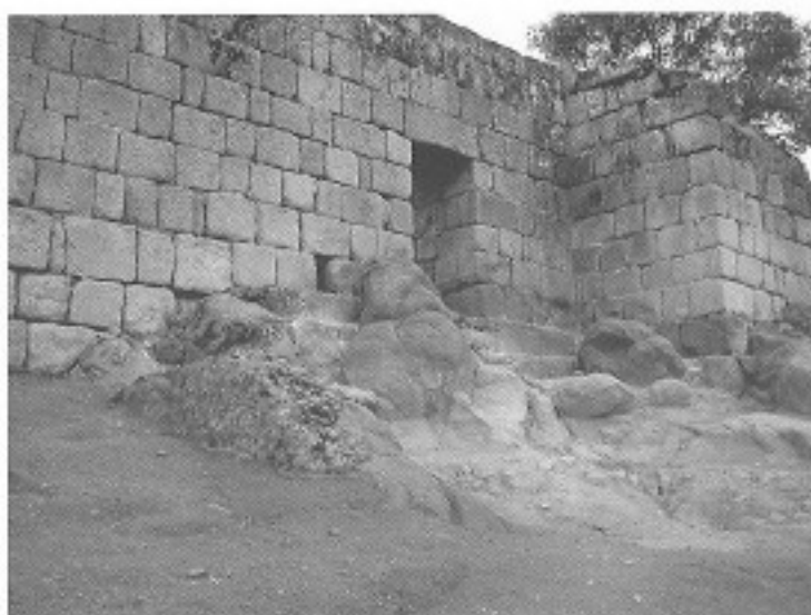
Fig. 10 - El Portillo 1, visto desde el exterior, tras su excavación.
