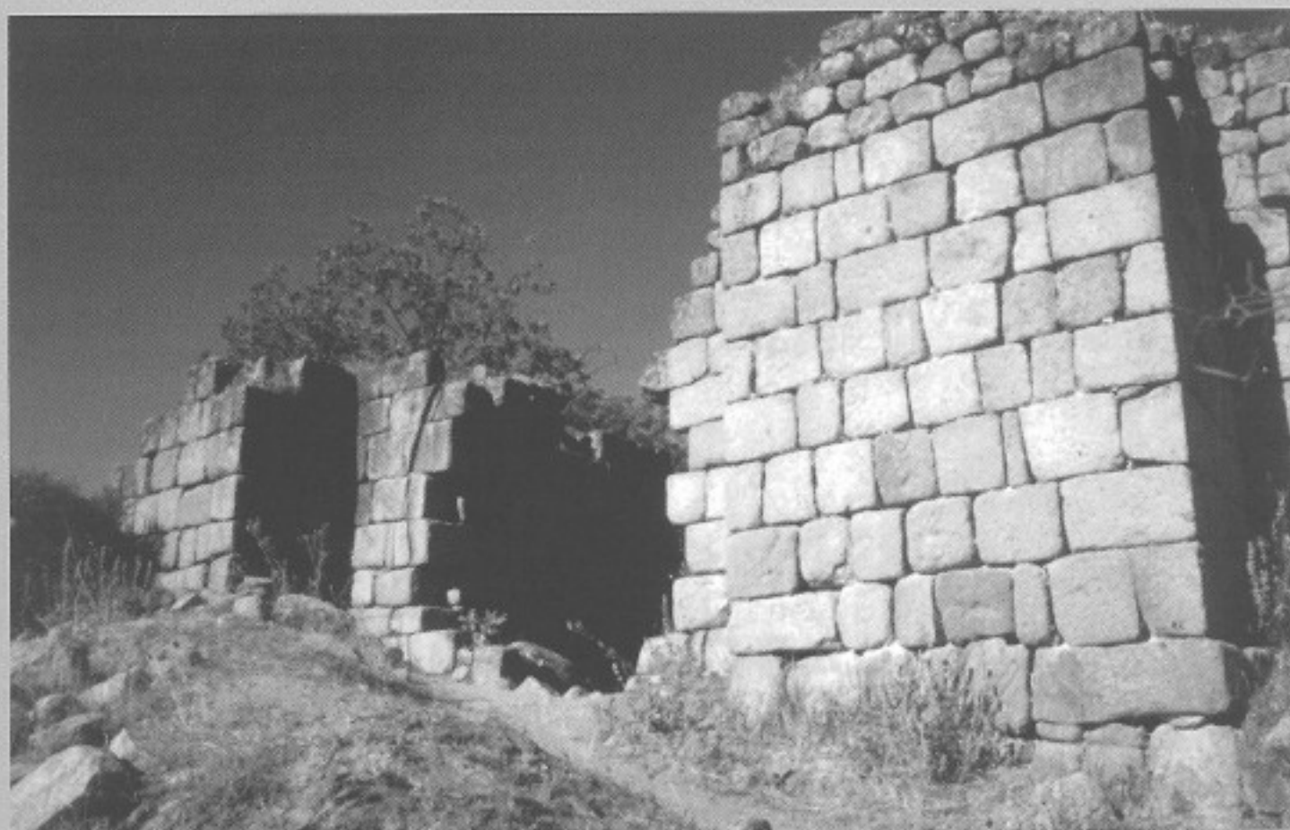
Fig. 2 - La Puerta Oeste antes de su excavación.
