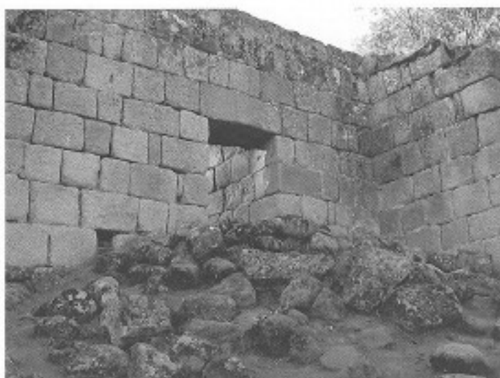
Fig. 9 - El Portillo 1, visto desde el exterior, antes de su excavación.
