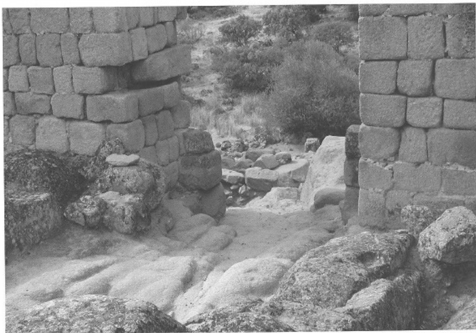
Fig. 4 - La Puerta Oeste vista desde el interior tras su excavación.
