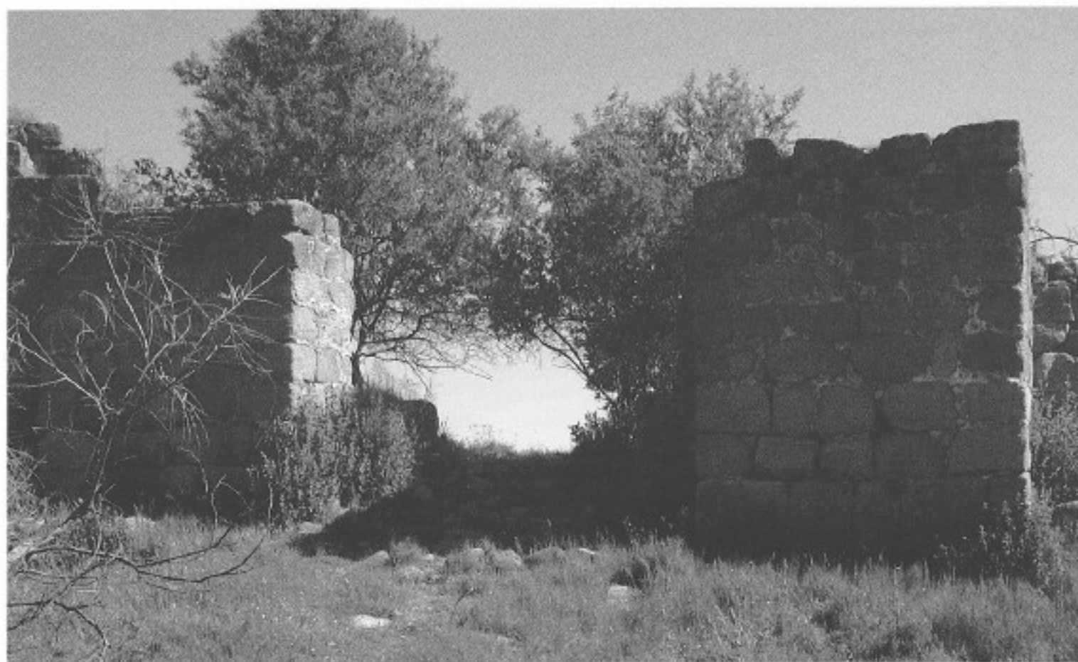
Fig. 5 - La Puerta Sur antes de su excavación.
