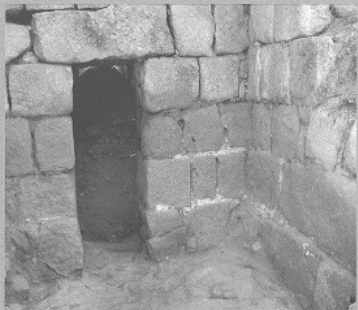
Fig. 18 - El Portillo 3, visto desde el exterior, tras su excavación.
