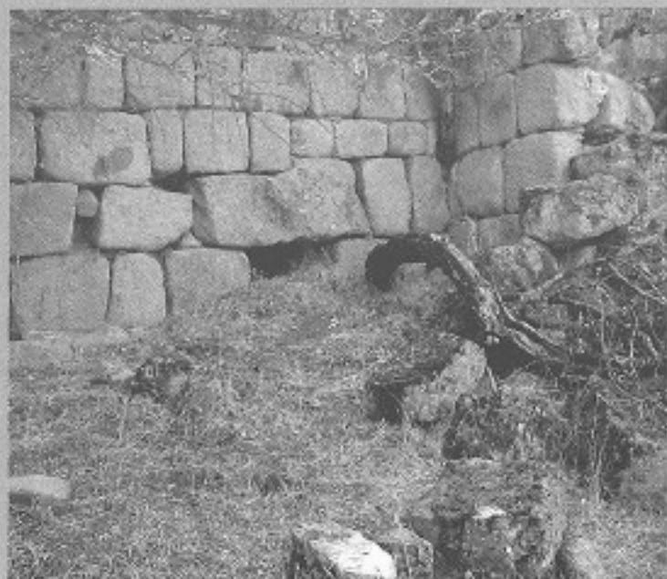
Fig. 17 - El Portillo 3, visto desde el exterior, antes de su excavación.
