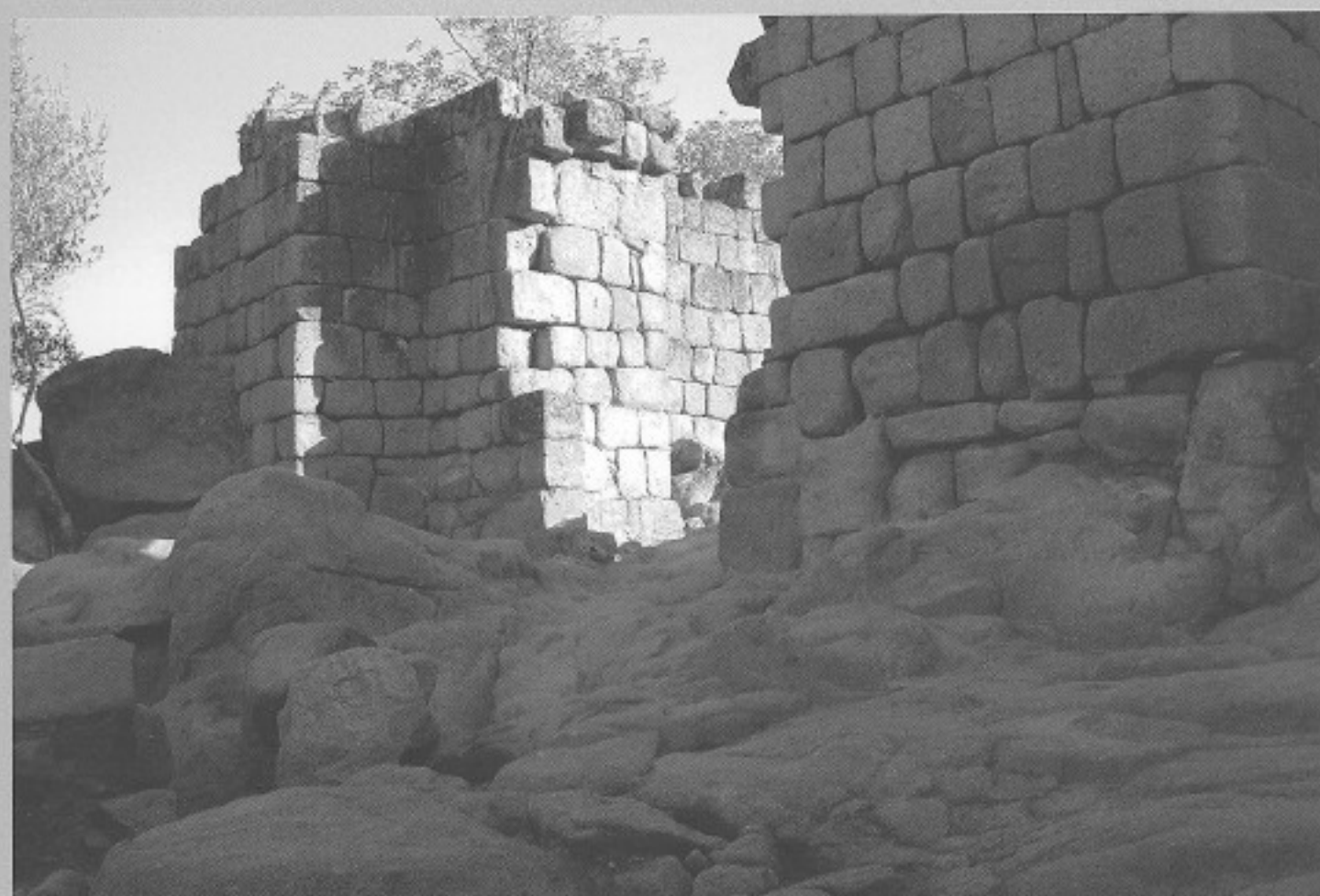
Fig. 3 - La Puerta Oeste tras su excavación.
