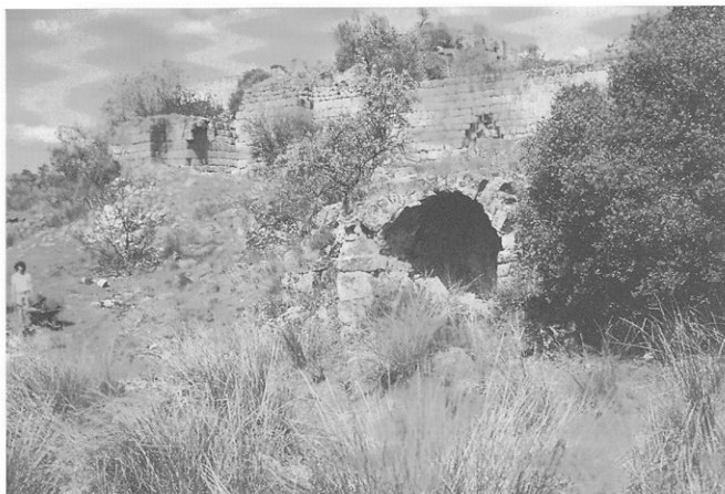
IV. Recintos abovedados de los baños árabes, conocidos como «Baño de la Mora».
