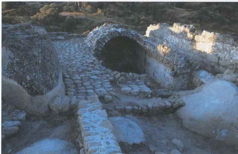
traría en el lado norte. Este aljibe tiene unas medidas de 7 m de largo, por 3,05 m de ancho y 2,60 m de altura hasta la clave del arco de la bóveda. Su capacidad sería de unos 37 m<sup>3</sup>.
