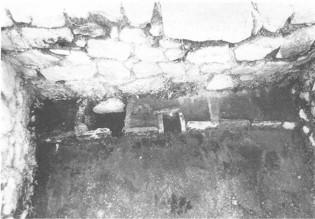
Lám. X: Estructura de ladrillos adosada al muro oeste de la dependencia 2 del edificio B, posibles restos de una cocina.
