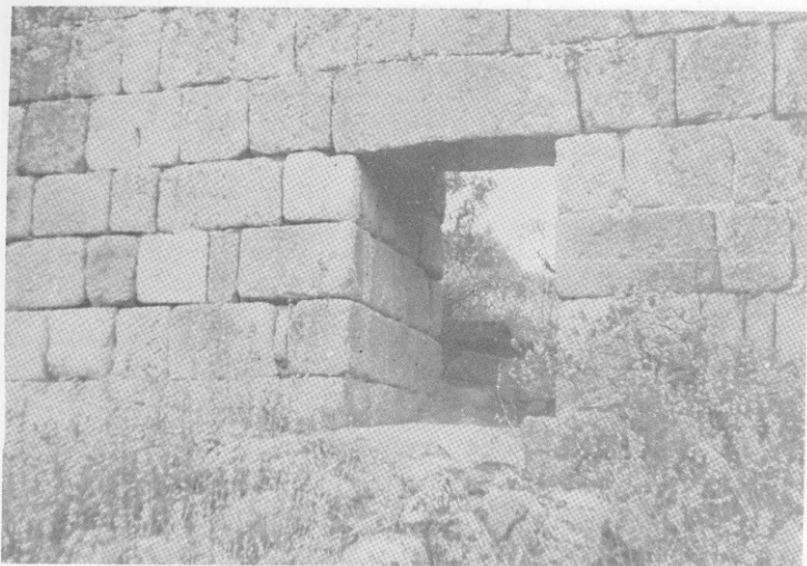
Fig. 6 : Petite porte de la muraille du secteur ouest.
