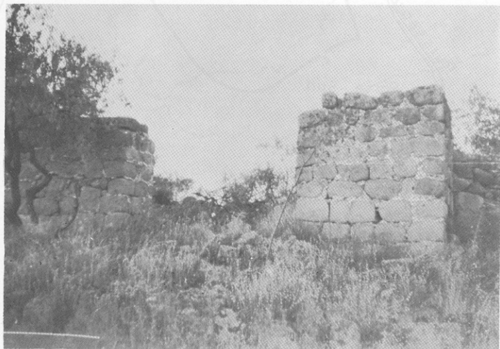
Fig. 4 : Les deux tours de la porte sud, laquelle se trouve actuellement effondrée.
