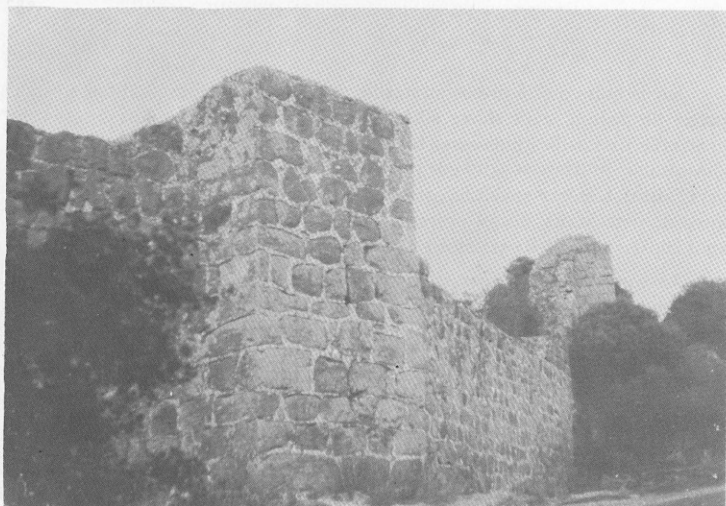
Fig. 7 : Remparts du secteur sud de la ville.
