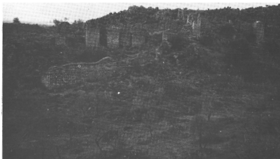
Lám. III.-1 Muralla y torreones del sector sur. Obsérvese la distinta construcción con respecto a la muralla del sector oeste de la foto n.º 2 de la lámina anterior. 2: Vista general de la Alcazaba y sus fortificaciones, desde el interior de la ciudad.
